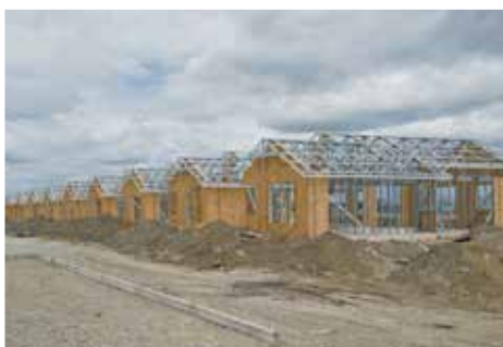
670 viviendas Puerto Montt
